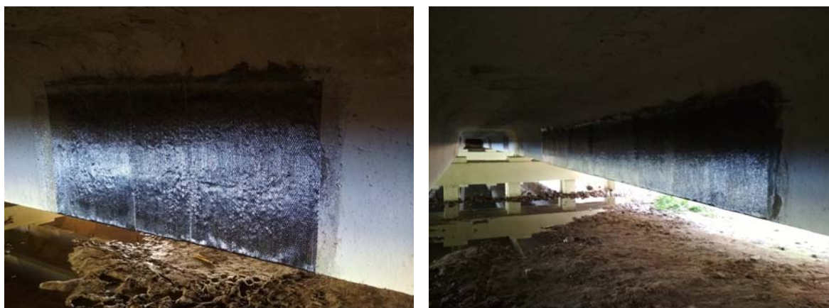
Рисунок 2 – Усиление ребра мостовой балки углеволокном
