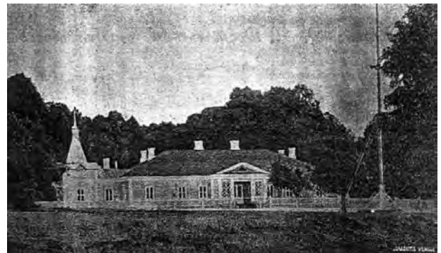
Рис. 7. Дом в Старом Борисове после реконструкции
