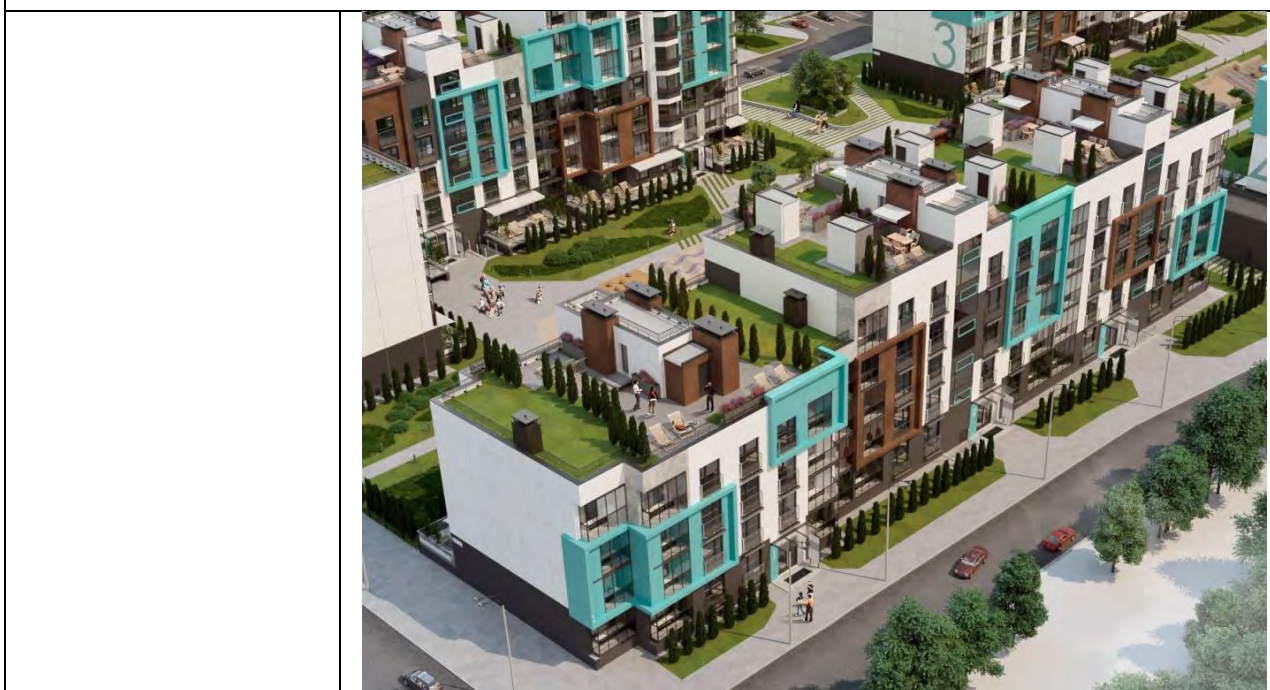
Рисунок 7. Зелёная эксплуатируемая кровля
