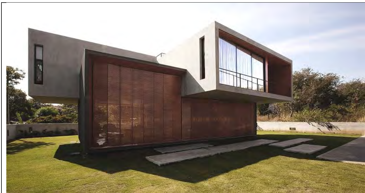
Рисунок 2. Дом «W-House» от студии IDIN Architects, Бангкок, 2011. Пример использования приема «обесцвечивания» в экстерьере. Передняя секция окон становится «непрозрачной» благодаря горизонтальным жалюзи. Цвет жалюзи, хоть и занимает значительную площадь сооружения, но не определяет архитектурное решение и может меняться без ощутимого влияния на дизайнерское решение здания
