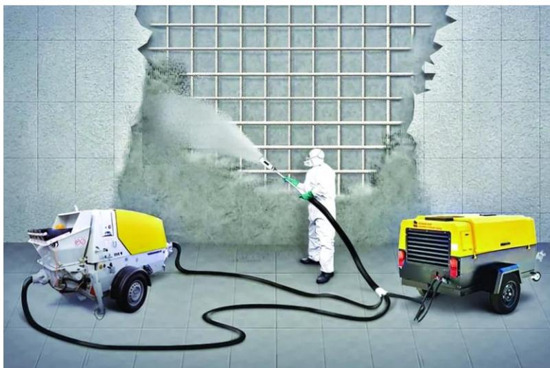
Рисунок 3 – торкретирование поверхности
