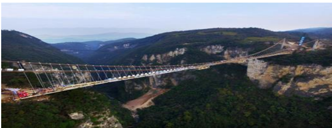
Рисунок 1 – Строительство стеклянного моста в Китае
