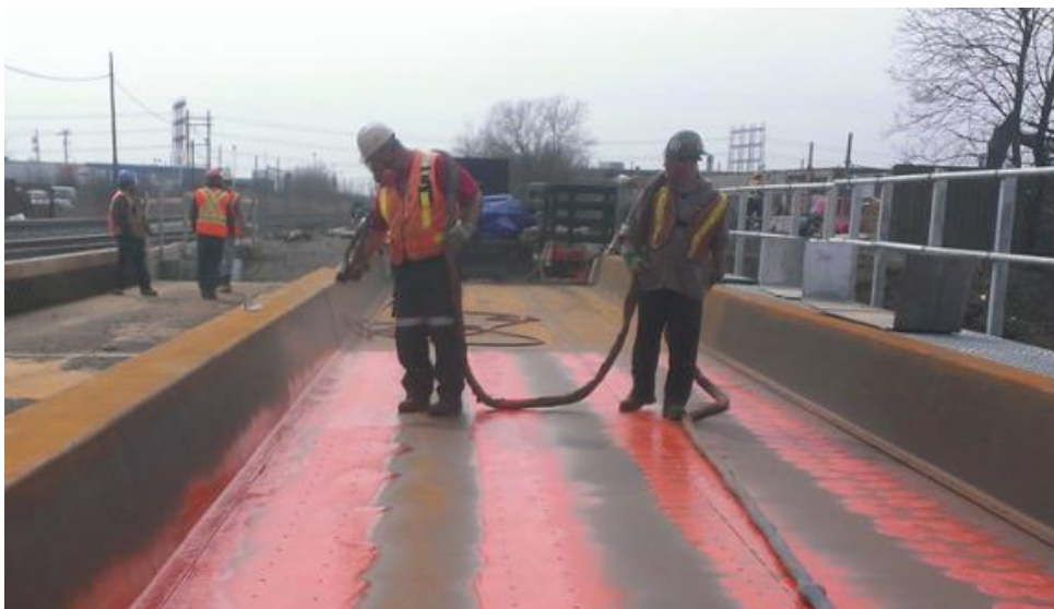
Рисунок 1 – Производство работ по укладке гидроизоляционной мембраны
