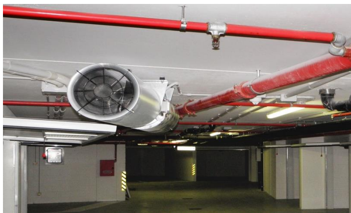
Рисунок 2 – Вытяжная противодымная система
