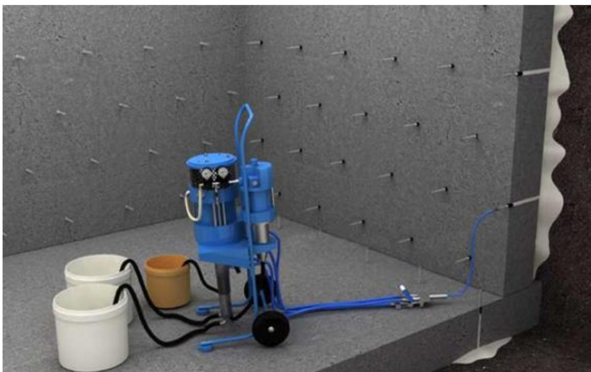
Рисунок 1 – инъектирование состава в стену фундамента
