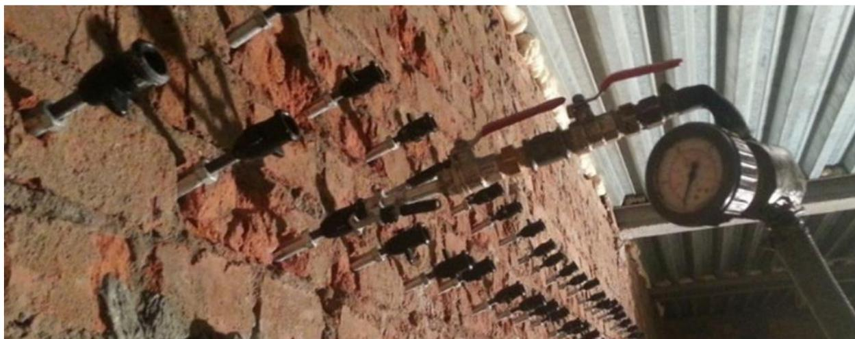
Рисунок 2 – подача смеси под давлением
