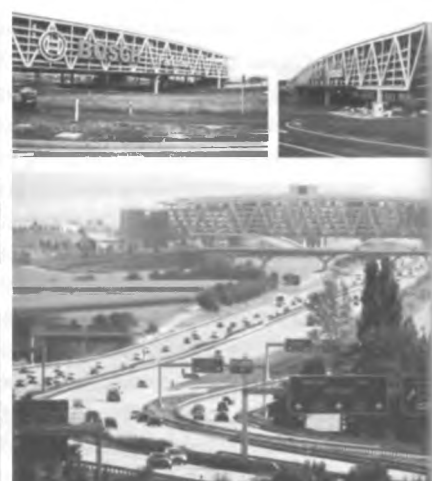
Рис. 8. Многоуровневая парковка-мост Neue Messe в Штутгарте
