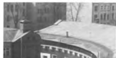
Рис. 5. Гараж на ул. Новорязанской в Москве (арх. К. Мельников, инж. В. Шухов). Конструкция покрытия (фото А. Родченко), фрагмент здания
