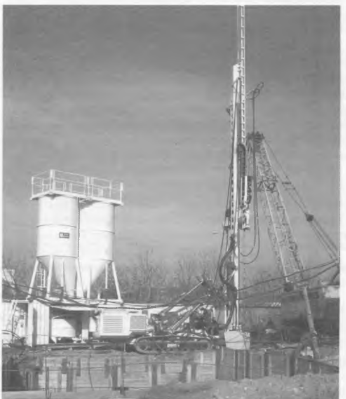
Рис. 12. Оборудование итальянской фирмы Soilmes для струйной технологии
