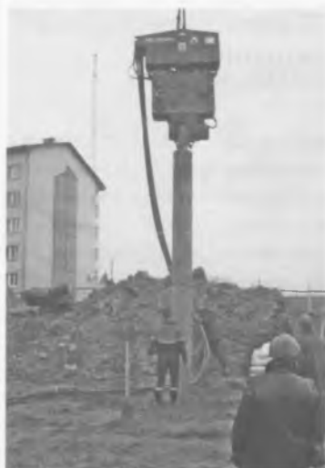
Рис. 4. Погружение труб подвесным безрезонансным вибропогружателем
