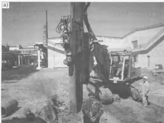
Рис. 2. Устройство вибронабивных свай:
