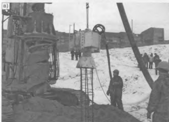
Рис. 6. Оборудование для устройства свай SFA: а — буровой станок со сплошным полым шнеком; б — буровой станок для проходки скважин; в — подъем шнека с бетоном на лопастях и погружение вибратором арматурного каркаса в скважину
