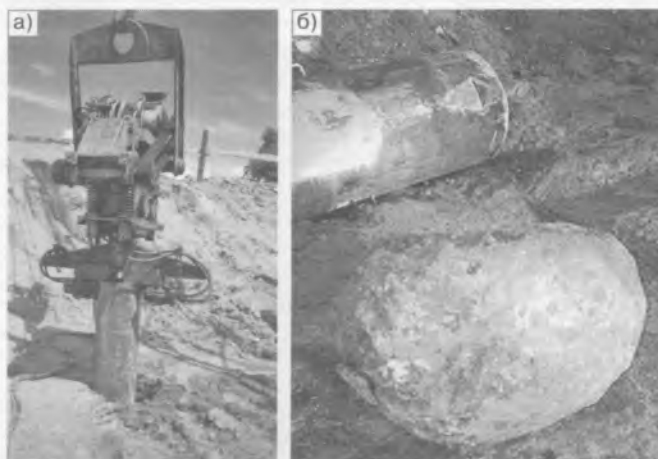
Рис. 1. Погружение стального пуансона подвесным вибратором при создании скважины для буронабивной сваи (а) и общий вид распорной выштампованной пяты (б)
