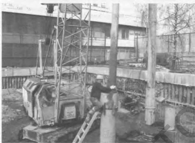
Рис. 3. Устройство буронабивных свай:
