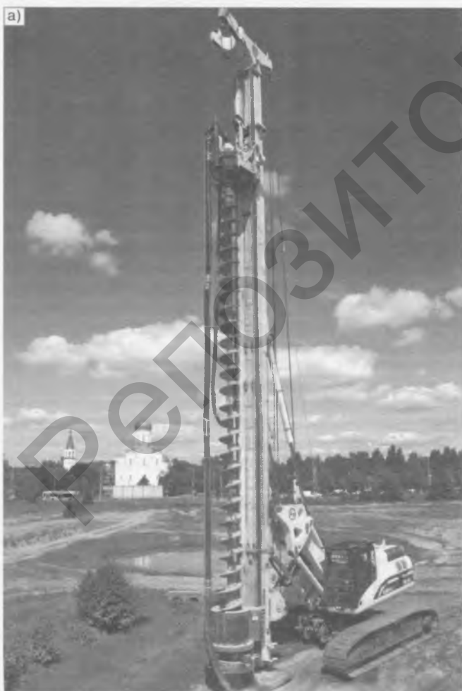
Рис. 6. Оборудование для устройства свай SFA: а — буровой станок со сплошным полым шнеком; б — буровой станок для проходки скважин; в — подъем шнека с бетоном на лопастях и погружение вибратором арматурного каркаса в скважину
