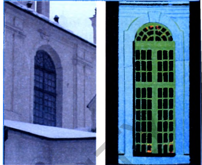
Рис. 6. Модель собора (триангуляционная поверхность)
