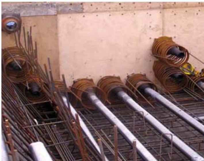
Рис. 4 – Опорные стаканы и спирали косвенного армирования
