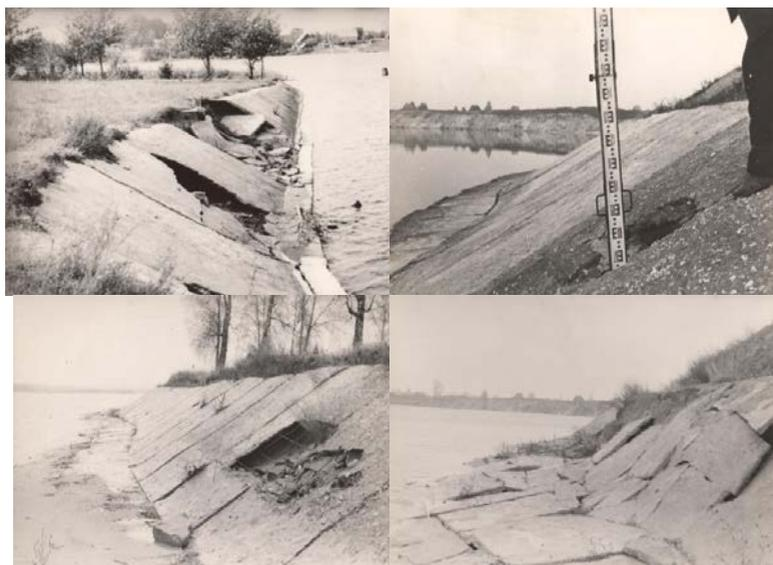
Рис. 2.11. Разрушение крепления берегов Лепельского водохранилища (1962 г.)
