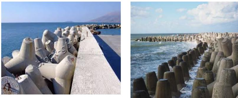
Рис. 1.23. Дополнительная пассивная берегозащита тетраподами
