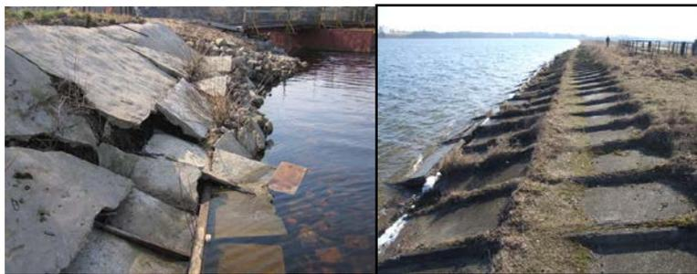
Рис. 3.3. Крепление берега на Смолевичском и Лепельском водохранилищах
