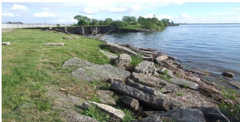
Рис. 8.10. Крепление берега отсыпки отработанных железобетонных конструкций. Лукомльская ГРЭС
