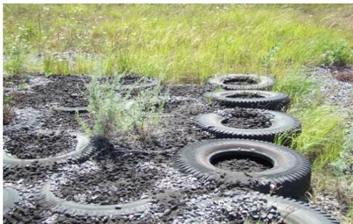
Рис. 2.26. Крепление откосов тьюфками из отработанных автопокрышек
