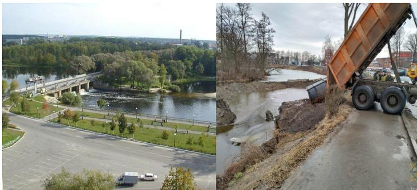
Рис.7.5. Обрушение откосов дамб обвалования ГЭС. г. Добруш (2019 г.)
