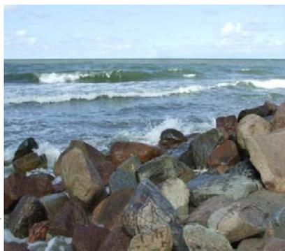
Рис. 1.28. Пассивная берегозащита габионами и каменной наброской.
