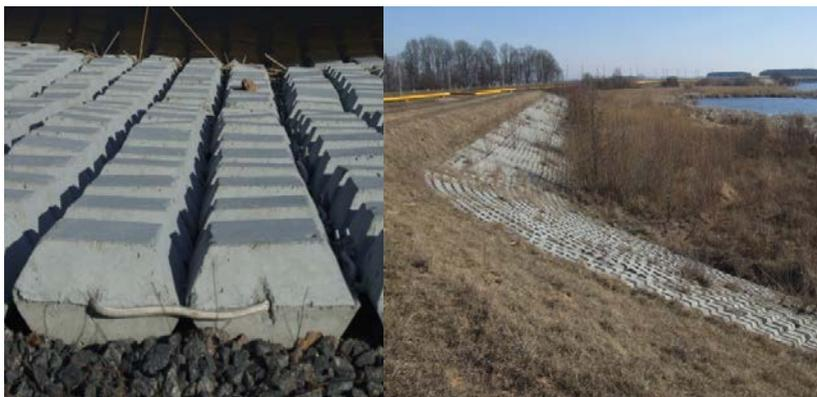
Рис. 8.9. Солигорское водохранилище. Гибкое крепление откосов
