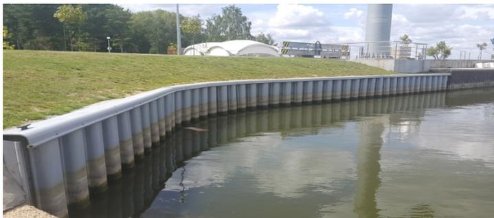
Рис. 1.32. Металлическая волноотбойная шпунтовая стенка
