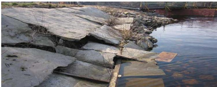
Рис. 3.1. Повреждение железобетонного монолитного крепления откосов
