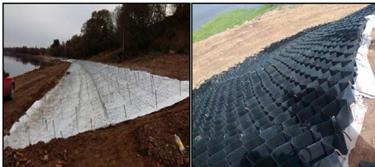
Рис. 8.6. Типы комбинированного крепления берега, используемые на водохранилище Витебской ГЭС
