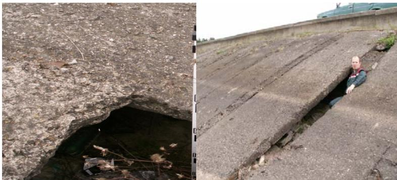
Рис. 7.2. Млынокское водохранилище. Разрушение крепления откоса (2010 г.)
