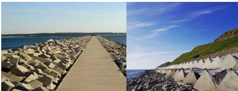
Рис. 1.25. Пассивная берегозащита фигурными блоками
