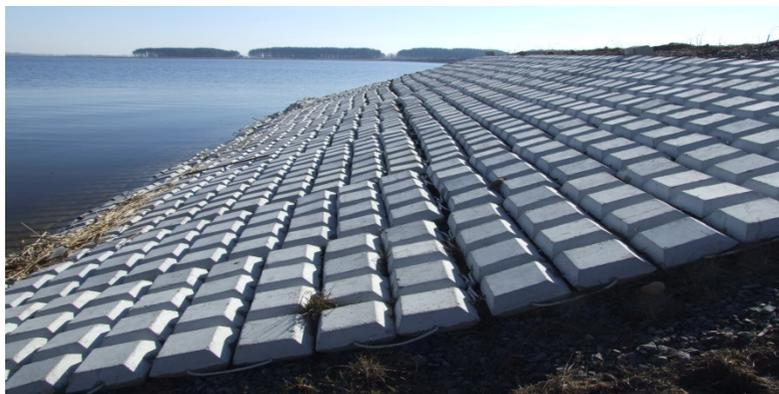
Рис. 8.7. Защита откосов гибким бетонным креплением. Солигорское водохранилище
