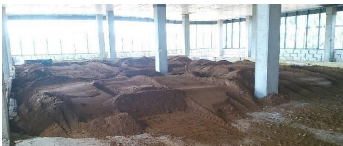
Рис. 1. Общий вид нагруженного фрагмента перекрытия
