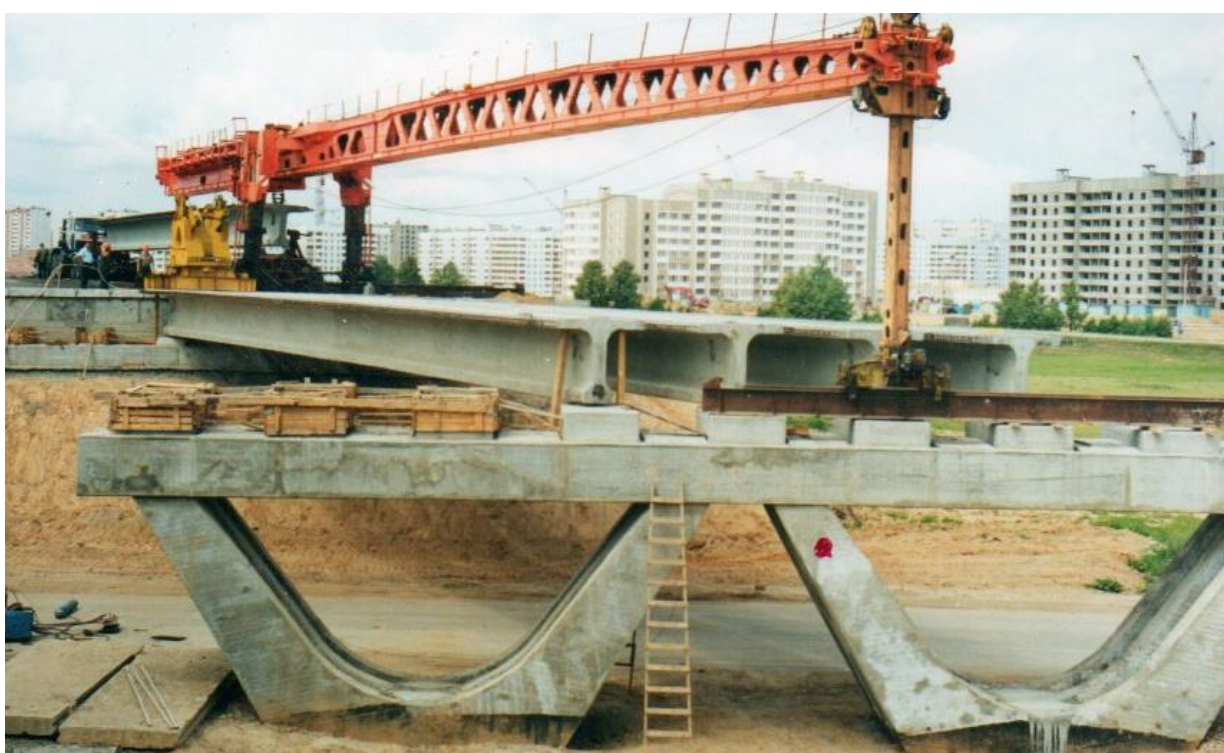
Рис. 2.1.10. Монтаж балок пролетного строения на рамную опору.
