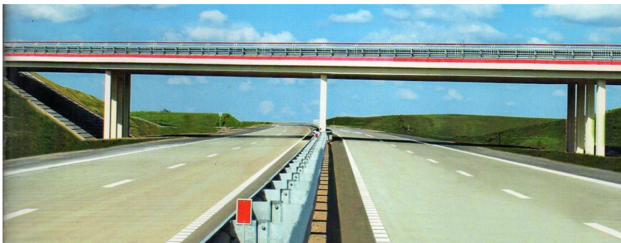
Рис. 2.1.9. Четырехпролетный балочный путепровод на дороге М-14.
