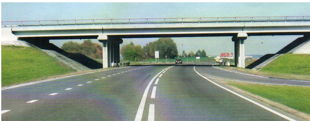
Рис. 2.1.8. Трехпролетный балочный путепровод.
