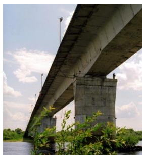
Железобетонный мост в Беларуси
