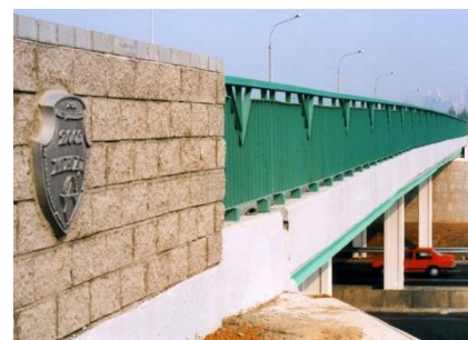
Парапет и перила путепровода
