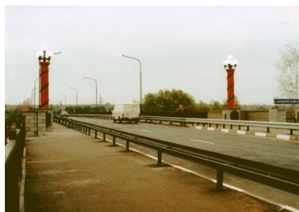
Светильники при въезде на мост
