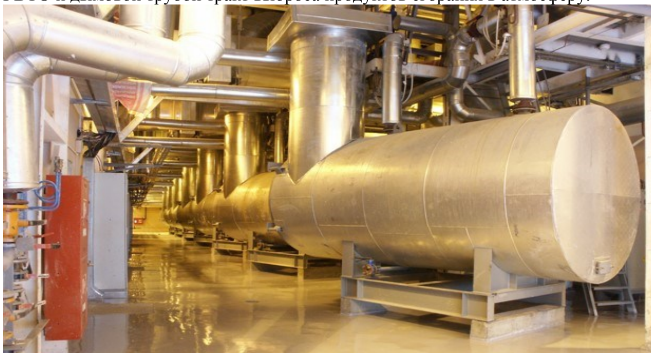
Рисунок 1. Газоводяные теплообменники
