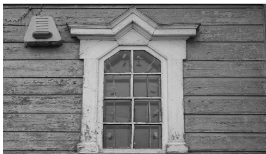
Мал. 3. Вакно 1900 г. з канструктыўнымі гарызантальнымі элементамі запаўнення. Царква ў Гарадзішчы Баранавіцкага раёна. Фота А. Яроменка
