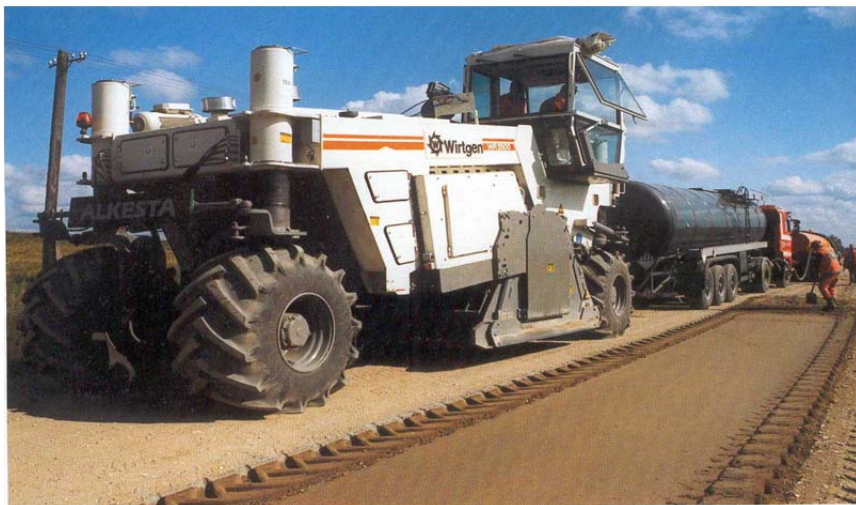
Рис. 10.1. Холодный «ресайклинг» дорожного покрытия
