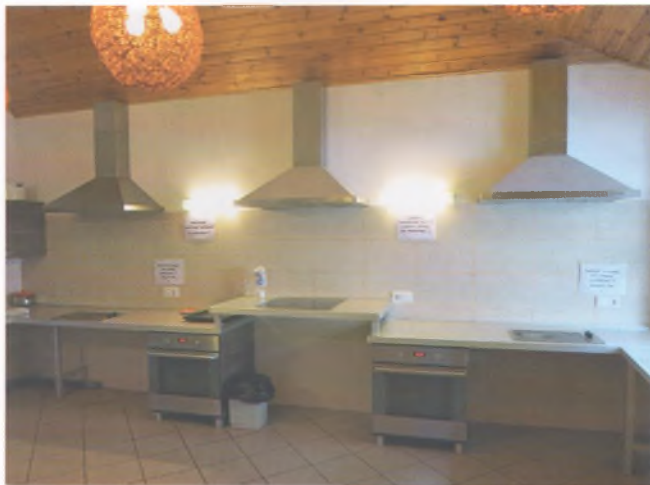
Рис. 7. Свободное пространство для ног и регулируемая высота кухонного оборудования в помещении общей кухни комплекса отдыха в курортном поселке Швянтойи позволяет самостоятельно готовить людям, использующим кресла-коляски
