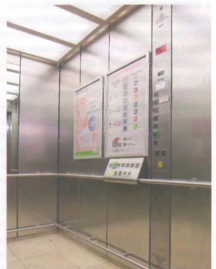
Рис. 6. Кабина лифта в торговом центре «Ozas» в Вильнюсе, оборудованная вертикальным и горизонтальным табло управления, позволяет использовать его людям, сидя в кресле-коляске, детям и людям низкого роста. Кнопки большого размера с указанием цифры номера этажа выполнены выпуклым шрифтом и продублированы шрифтом Брайля. Дополнительно работает звуковое сопровождение
