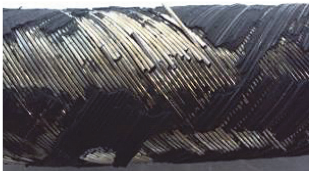
Рис. 8. Разрушение проволоки на боковой поверхности предоставленного фрагмента
