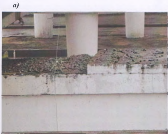
Рисунок 1 – Загрязнение избытком щебня поверхности опор: а – на русловой опоре; б – на береговой опоре
