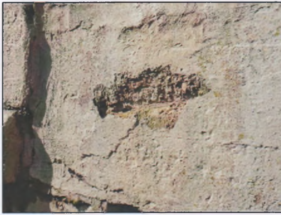
Рисунок 3 – Раковины и каверны на опорах: а – поверхностная раковина; б – каверны на опоре путепровода
