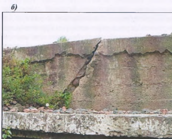
Рисунок 1 – Загрязнение избытком щебня поверхности опор: а – на русловой опоре; б – на береговой опоре
