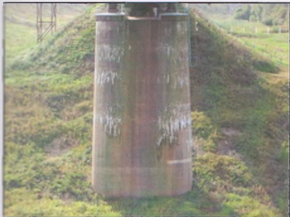
Рисунок 8 – Высолы (а) и сталактиты (б) на бетонной поверхности
