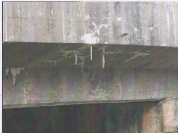
Рисунок 8 – Высолы (а) и сталактиты (б) на бетонной поверхности
