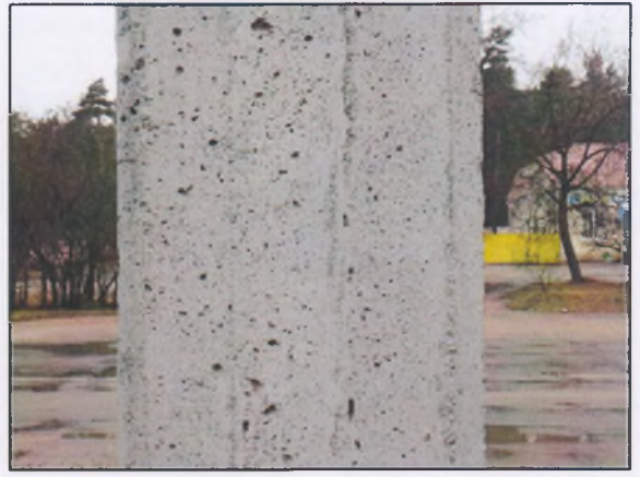
Рисунок 3 – Раковины и каверны на опорах: а – поверхностная раковина; б – каверны на опоре путепровода
