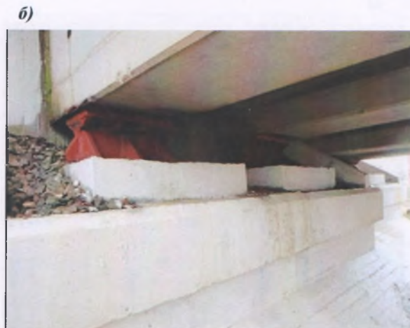
Рисунок 1 – Загрязнение избытком щебня поверхности опор: а – на русловой опоре; б – на береговой опоре
