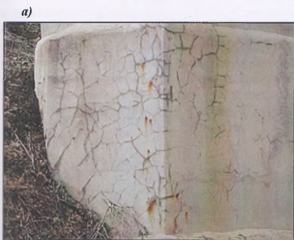
Рисунок 1 – Загрязнение избытком щебня поверхности опор: а – на русловой опоре; б – на береговой опоре
