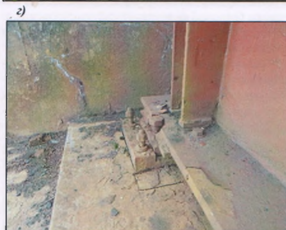
Рисунок 2 – Трещины в железобетонных конструкциях: а – по защитному слою опоры моста; б – в плите пролетного строения; в – силовая из-за защемления пролетного строения; г – в зоне опирания
