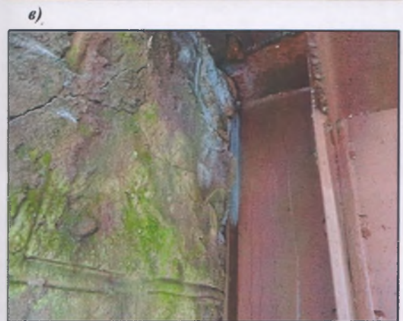
Рисунок 2 – Трещины в железобетонных конструкциях: а – по защитному слою опоры моста; б – в плите пролетного строения; в – силовая из-за защемления пролетного строения; г – в зоне опирания
