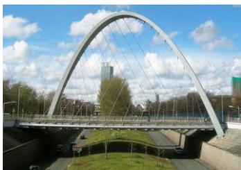
Пешеходный мост Hulme Arch, построенный в Манчестере (Англия). Его длина составляет 52 метра, ширина – 18 метров, а масса – 365 тонн. При строительстве конструкции использовали бетон и сталь, а его пешеходная поверхность
