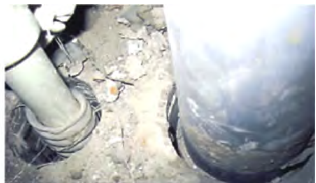
Рис. 13. Проход труб через междуэтажные перекрытия
