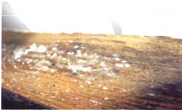
Рис. 6. Последствия отсутствия огнебиозащиты
