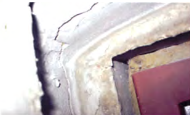
Рис. 9. Нарушения при установке противопожарных дверей
