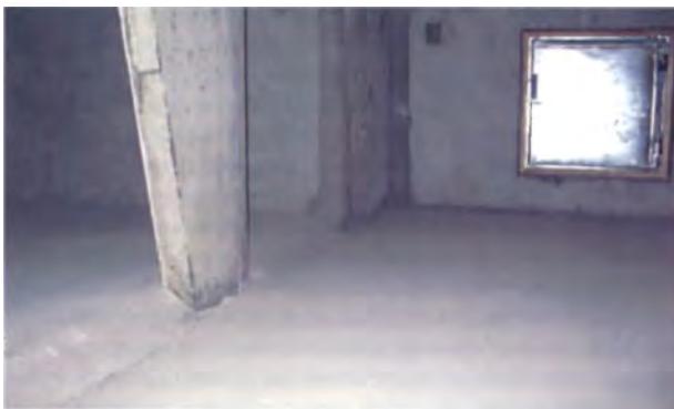
Рис. 8. Частичное утепление перекрытия
