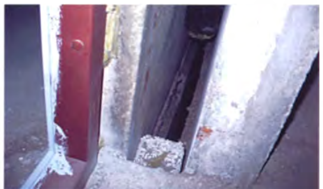
Рис. 10. Сопряжение двух секций здания
