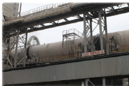
Рисунок 2 – Цех обжига клинкера на Белорусском цементном заводе
