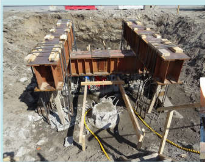
Испытательная установка. Опора №32
