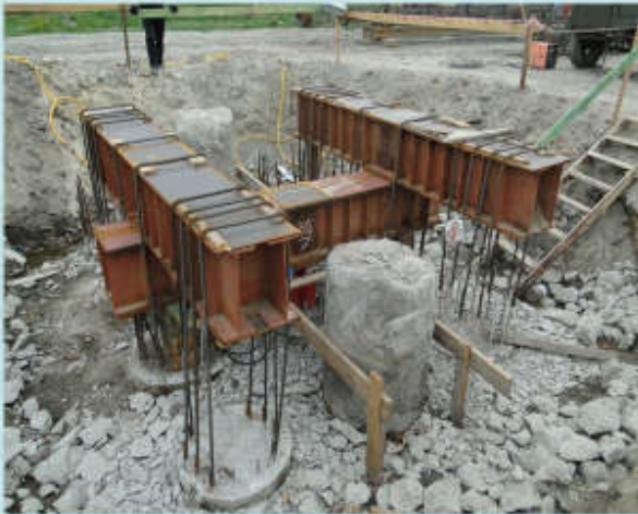
Испытательная установка опоры №31
