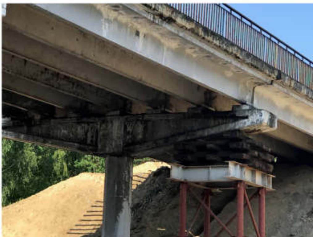
Опора путепровода на автодороге М10 у г.Лунинец
