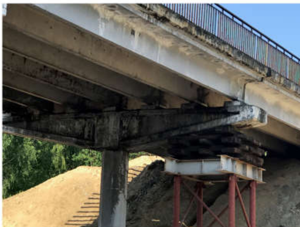
Опора путепровода на автодороге М10 у г.Лунинец
