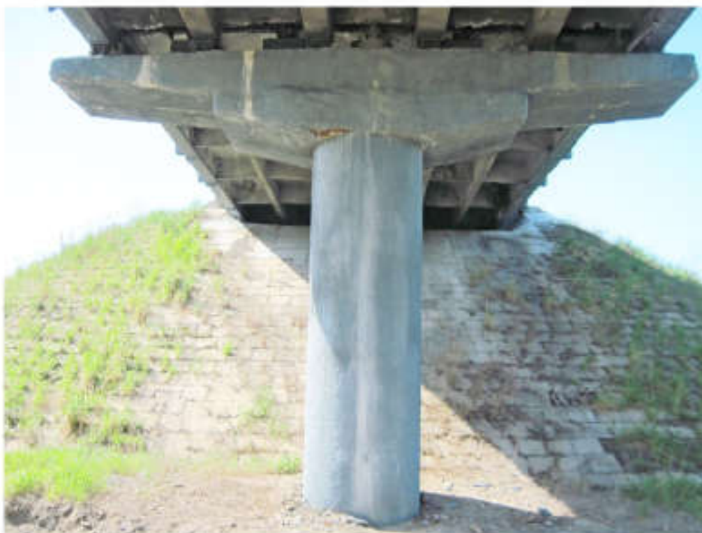
Опора путепровода на автодороге М10 у г.Калинковичи
