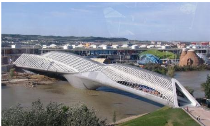
Рисунок 3. Мост-павильон в Сарагосе: а – здание; б - связь конструкций и выставочных пространств
