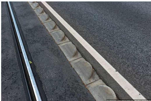
Рисунок 9 – Выделение трамвайного полотна с использованием бетонных элементов специальной формы
