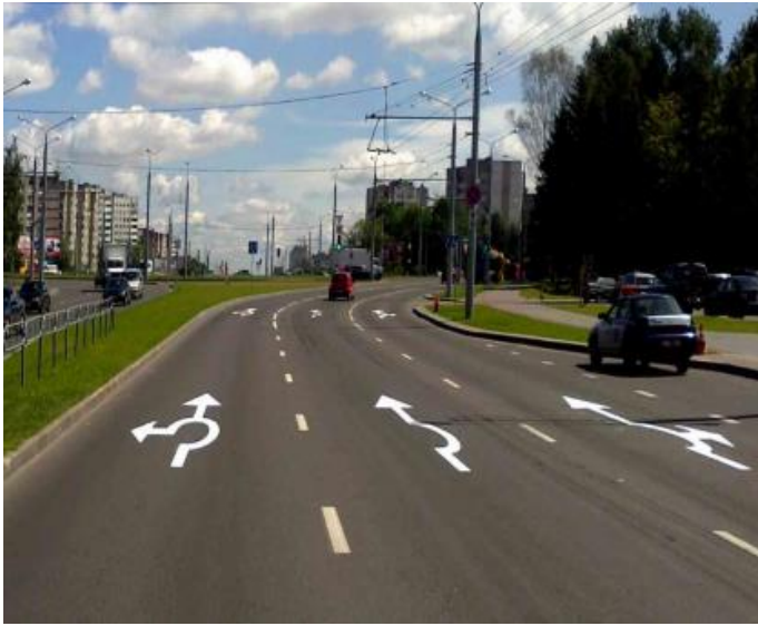
Рисунок 14 – Специальная дорожная разметка «Направления движения по полосам» на одном из подходов к кольцевой развязке в одном уровне
