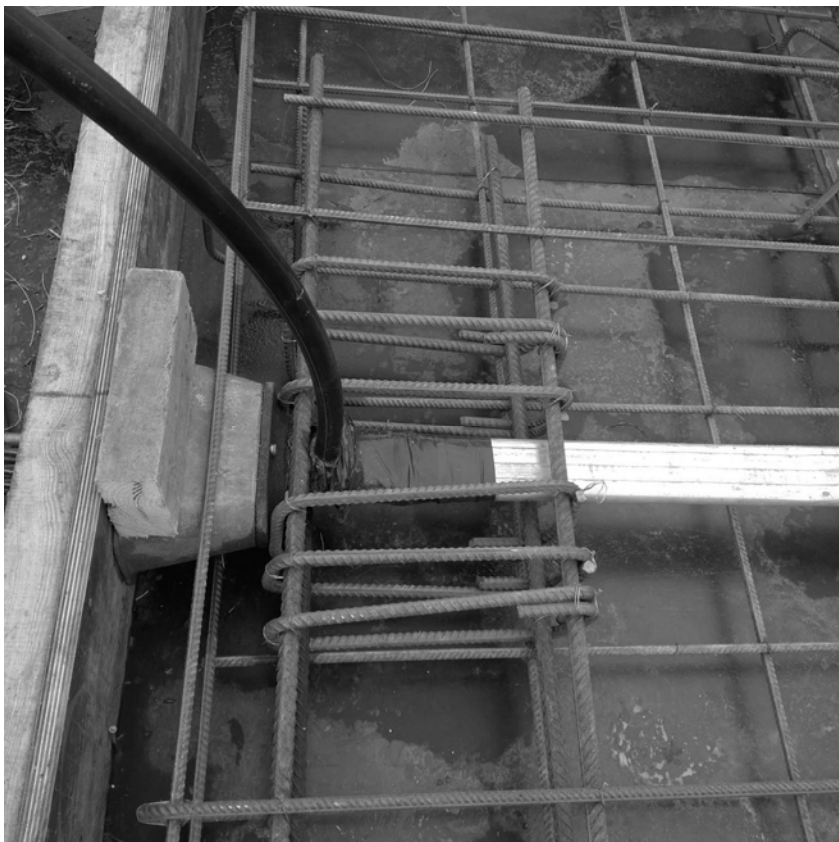
Рис. ПЗ.6. Анкерный узел в сборе.
