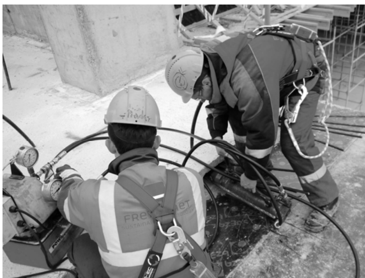
Рис. ПЗ.14. Установка домкрата в рабочее положение при расположении анкера на торце плиты
