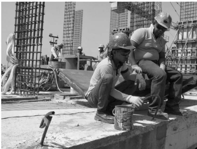
Рис. ПЗ.19. Процедура инъектирования. Рабочий следит за консистенцией вытекающего через штуцер раствора
