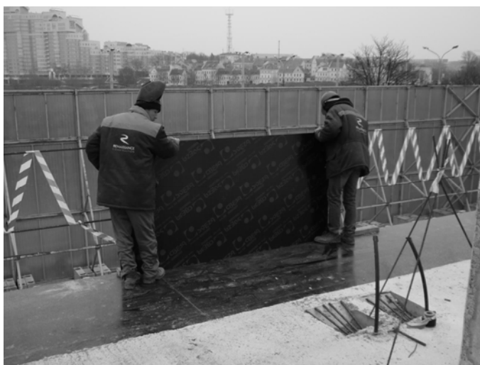
Рис. ПЗ.12. При натяжении у края конструкции существует риск падения домкрата вниз при обрыве пряди, потому необходимо установить защитный щит напротив точки натяжения
