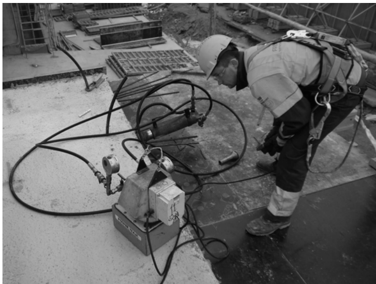
Рис. ПЗ.15. При натяжении выполняется непрерывный контроль давления в гидравлической системе
