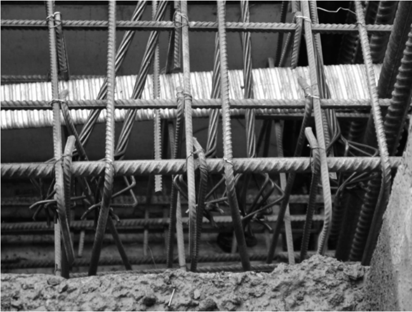
Рис. ПЗ.7. Луковицеобразные анкера на пассивных концах прядей
