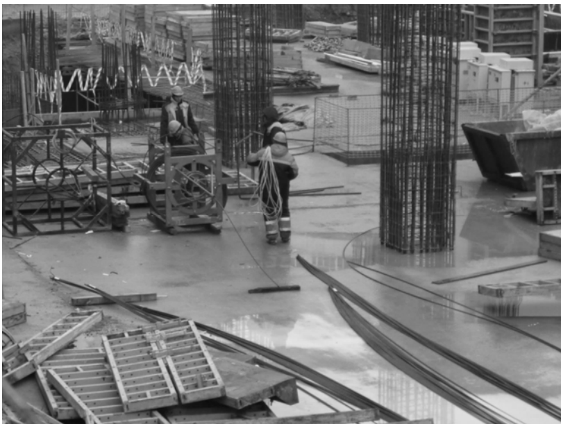
Рис. ПЗ.9. Пост предварительной нарезки прядей
