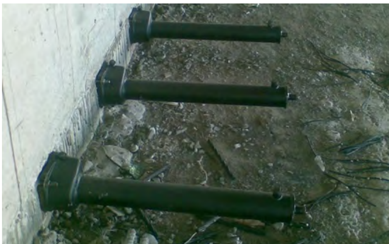
Рис. П2.3. Защитные колпаки активной стороны системы monostrand
