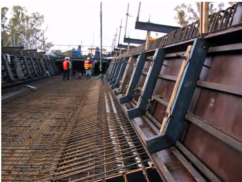
Рис. 1.12. Укладка арматуры в скользящую опалубку
