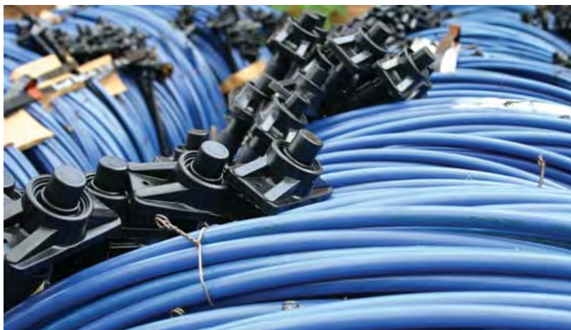
Рис. 2.1. Поставка компонентов системы unbounded monostrand
