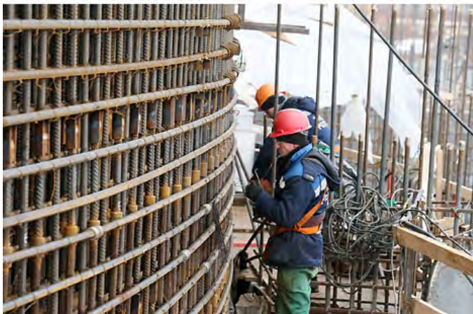
Рис. 4.42. Пример выполнения работ по устройству защитной оболочки
