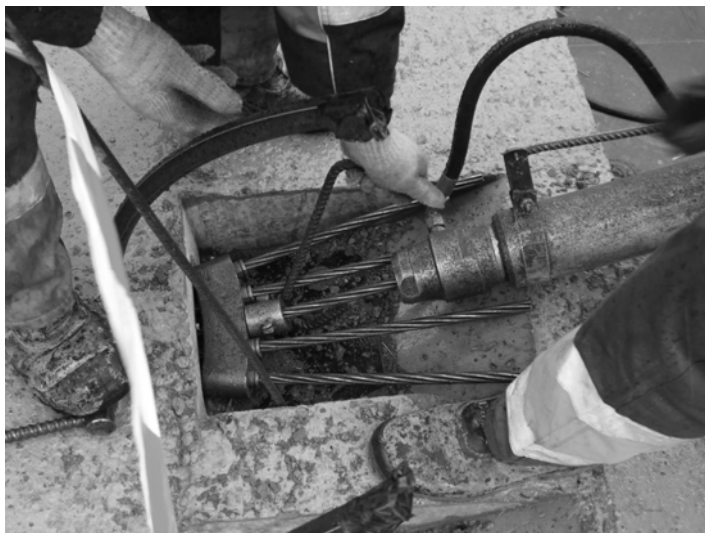
Рис. ПЗ.13. Установка домкрата в рабочее положение при расположении анкера на верхней грани плиты
