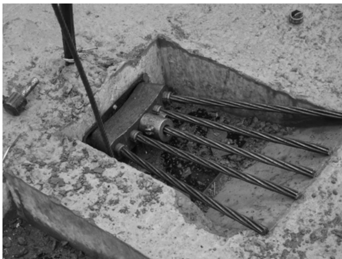
Рис. ПЗ.11. Анкерный блок и цанги, установленные в положение перед натяжением. Проставка на пряди служит для правильного приложения усилия при возможности отклонения оси домкрата от оси пряди
