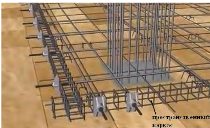
Рис. П2.2. Установка пространственных каркасов
