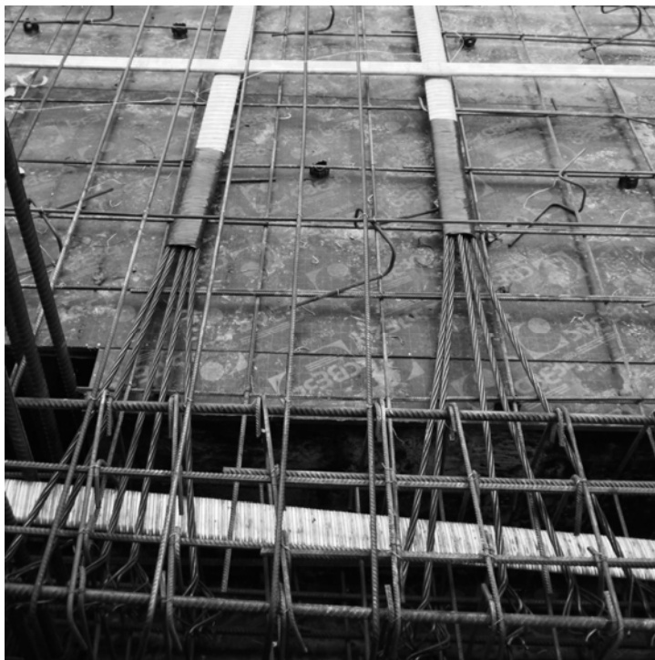
Рис. ПЗ.8. Герметизация каналаобразователя с пассивной стороны пучка клеейкой лентой
