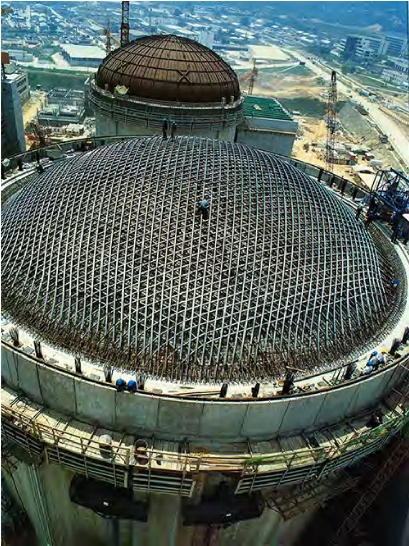
Рис. 1.17. Защитная оболочка ядерного реактора по системе freyssinet Daya-Bay (China, Китай)
