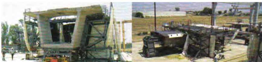
Рис. 1.14. Бетонирование секций коробчатого сечения по методу match casting [8]
