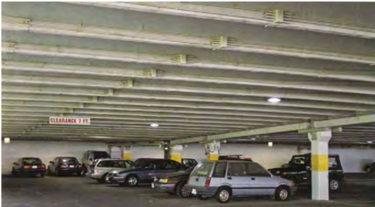
Рис. 1.3. Пример усиления конструкций перекрытия паркинга предварительно напрягаемыми канатами, расположенными вне бетонного сечения. Retail Store Parking Garage, Springfield [10]
