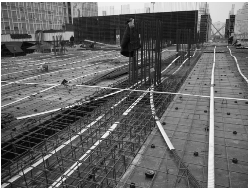
Рис. ПЗ.10. Монтаж системы предварительного напряжения. Общий вид конструкции
