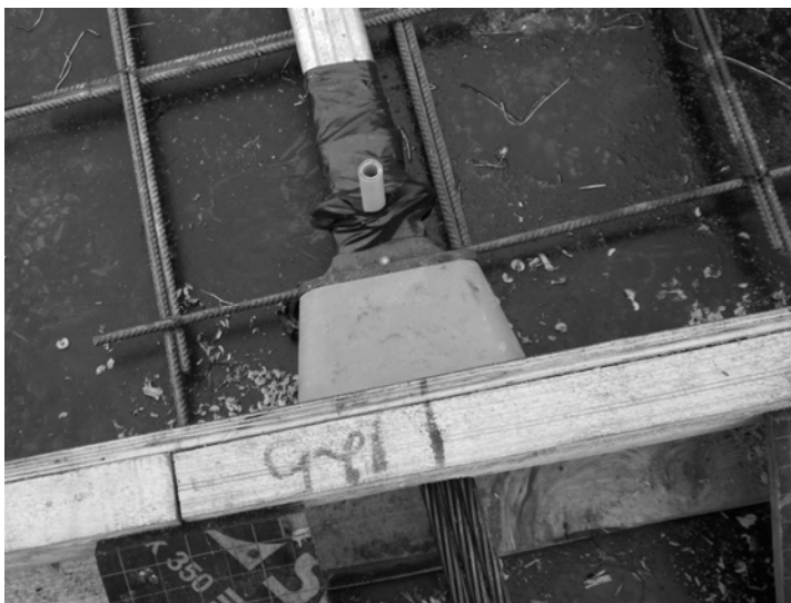
Рис. ПЗ.5. Монтаж анкерного узла. На опалубке отмечено место установки закладной детали и нанесен номер пучка. Деталь между закладной и бортом опалубки – нишеобразователь
