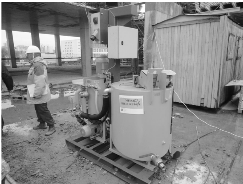
Рис. ПЗ.18. Смесительная станция для приготовления инъекционного раствора, один из вариантов исполнения
