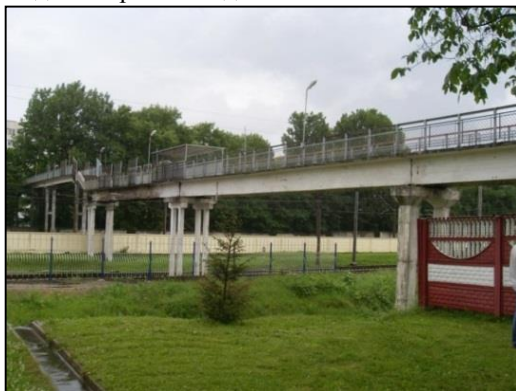
Общий вид сооружения до реконструкции
