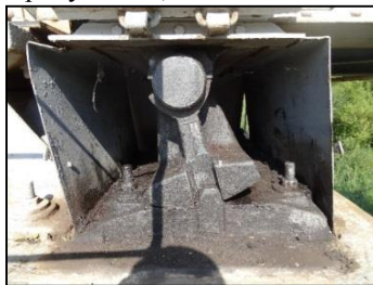
Рисунок 2 – Угон опорной части, выработка опорных зубьев
