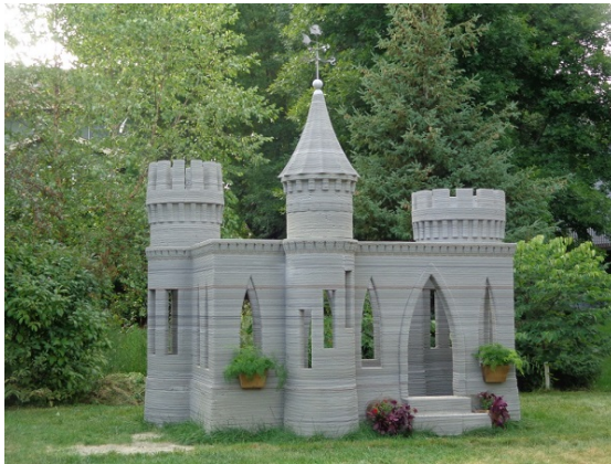
Рис. 2. Замок, выполненный с помощью 3D-принтера «StroyBot» Андрея Руденко
