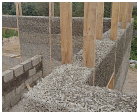
Рис. 2. Строительство каркасного дома со стенами из арболита
