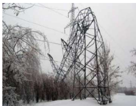
Рисунок 2 – Разрушенная опора ЛЭП под воздействием голо лёда
