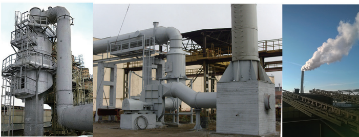
Системы мокрой пылегазоочистки: Минский тракторный завод, 2015г.
