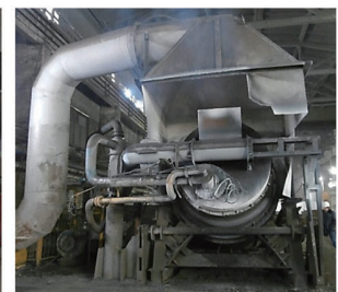
15-тонная РНП для рецилинга свинецсодержащих отходов ЗАО КПВР «Сплав» (г.Рязань, РФ, 2015г.)
