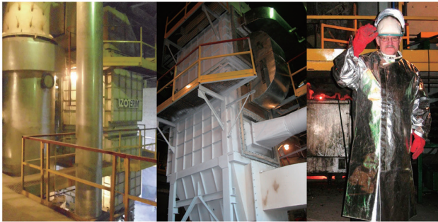
Система рекуперации и подгрева дутья для минераловатной вагранки (завод «ИзоТерм», Усть-Каменогорск, Казахстан, 2011г.)
