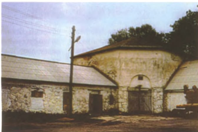
Чугунолитейный завод в Вишнево, Ошмянского уезда
