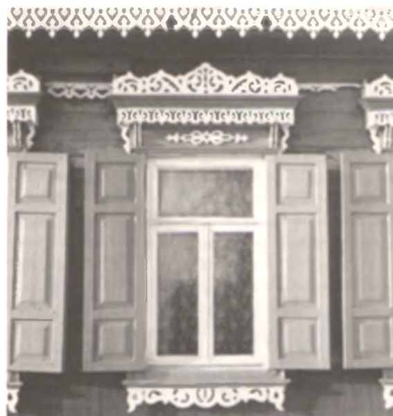
Окна жилого дома в Волосовичах Чечерского района
