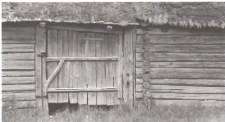
Конструкция ворот хлева в Иванковщине Мозырского района
