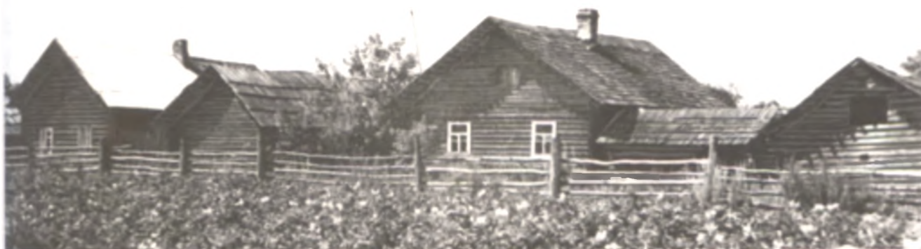
Поозерье. Жилая застройка в Озерцах Лепельского района
