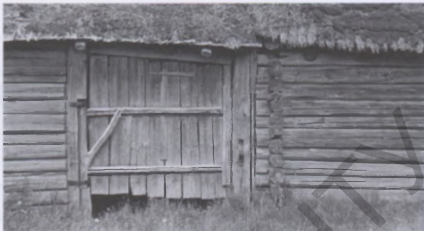
Конструкция ворот хлева в Иванковщине Мозырьского района
