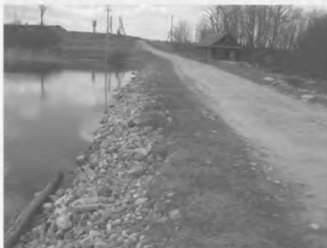
Рис. 1. Земляная плотина ГЭС «Алешино» на реке Зарежанке
