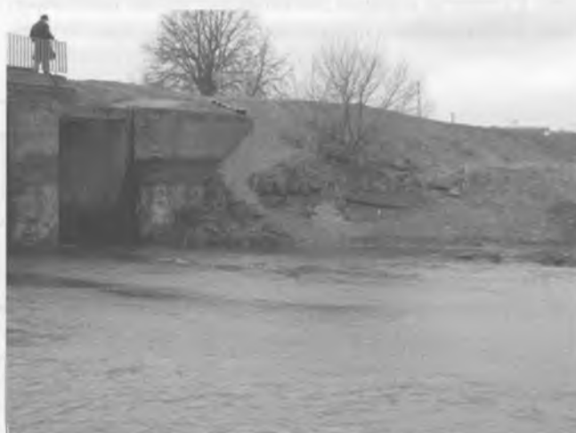
Рис. 2. Земляная плотина водохранилища «Саковщинское» на реке Западная Березина
