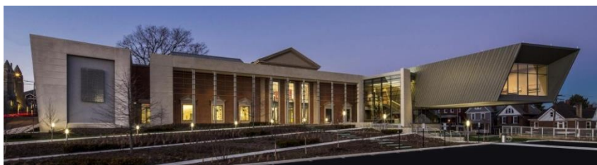
Рисунок 6 - Уэстмордлендский музей Американского искусства в Гринсбурге (США), архитектурная студия «Эннеад архитектс», 2015 г. а) до реконструкции, б) после реконструкции
