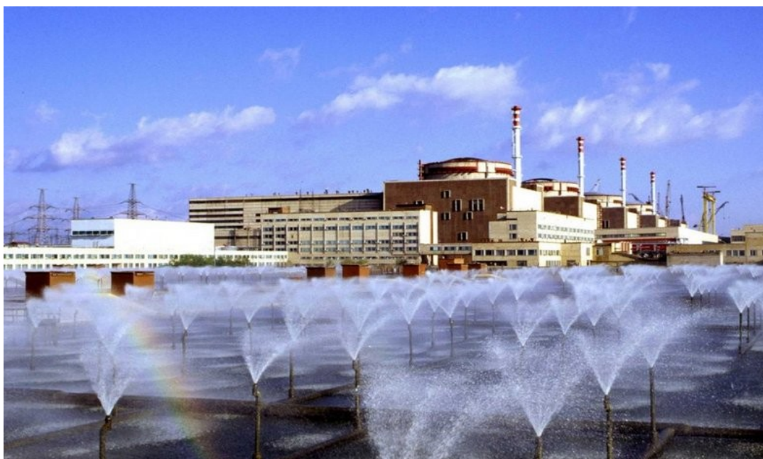
Рисунок 1 – Общий вид брызгального бассейна
