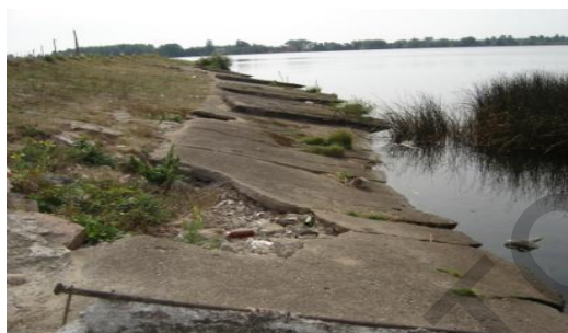
а)– водохранилище Любанское; б)– водохранилище Лепельское Рисунок 15. – Типичные разрушения креплений откосов и берегов (2015 г.)
