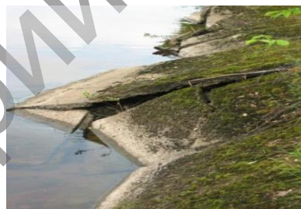
а)– водохранилище Любанское; б)– водохранилище Лепельское Рисунок 15. – Типичные разрушения креплений откосов и берегов (2015 г.)
