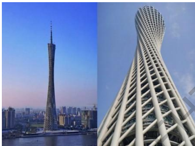
Рис. 5. Криволинейная форма башни, полученная из прямолинейных трубобетонных элементов.
