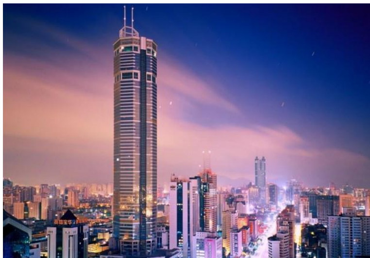
Рис. 4. Построенное с использованием трубобетона 72-этажное здание «SEG Plaza».
