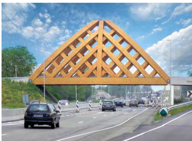
Рисунок 2 – Путепровод в г. Снек, пересекающий автомагистраль А7
