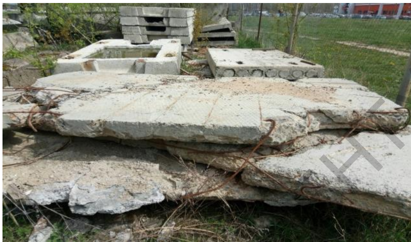
Рис. 2. Сплошная железобетонная плита
