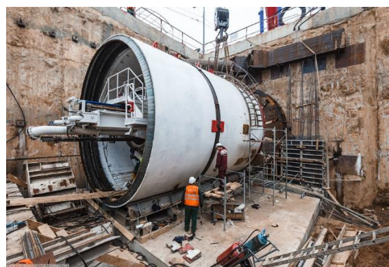
Рисунок 3 – Строительство тоннеля метрополитена щитовым способом
