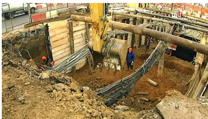
Рисунок 2 – Строительство подземного пешеходного перехода открытым способом
