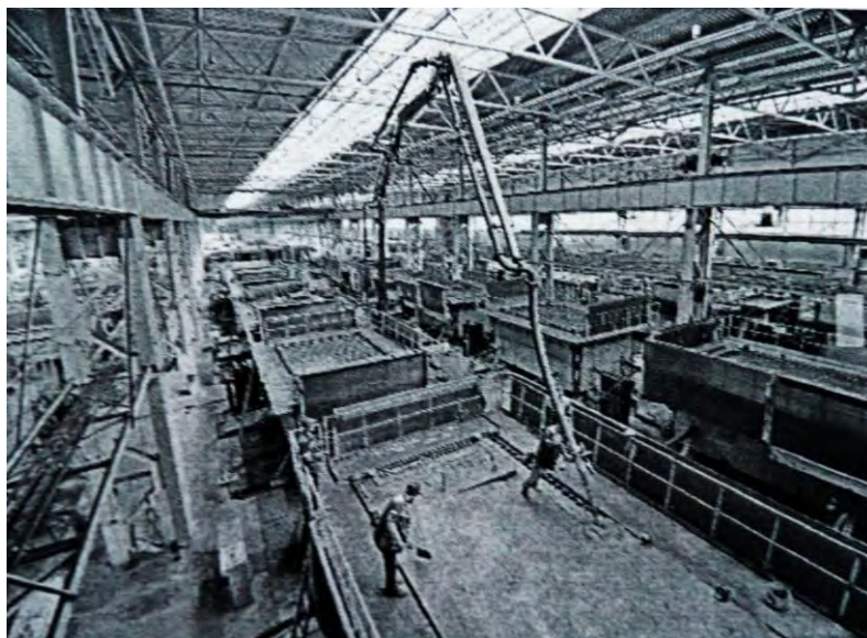
Рис. 122 – Бетонирование блок-комнаты типа «колпак».
